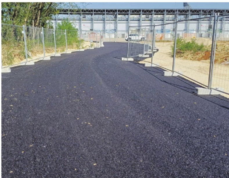
La strada che collega viale Olimpia con via Michelangelo realizzata dalla Provincia
