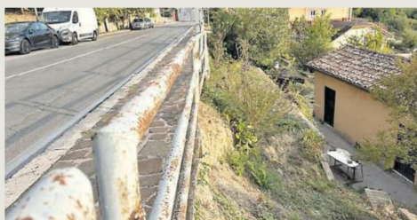
Il marciapiede "pensile" di viale Napoli
