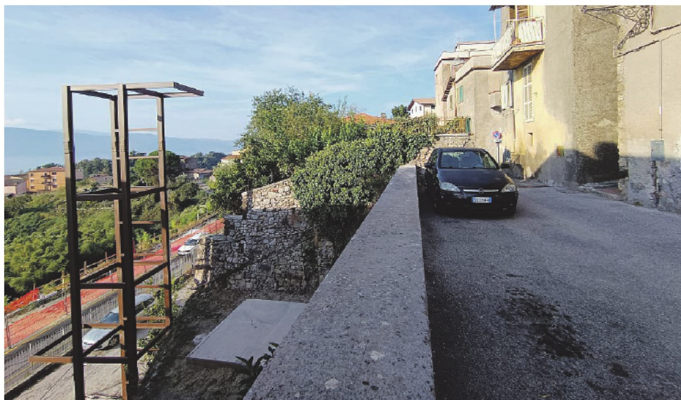
Uno degli scheletri in acciaio che servono per gli ascensori a servizio dei nuovi parcheggi
