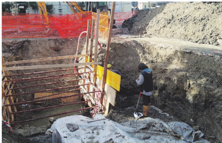
Alcune immagini dei lavori e dell'incontro pubblico su piazza Palestro
