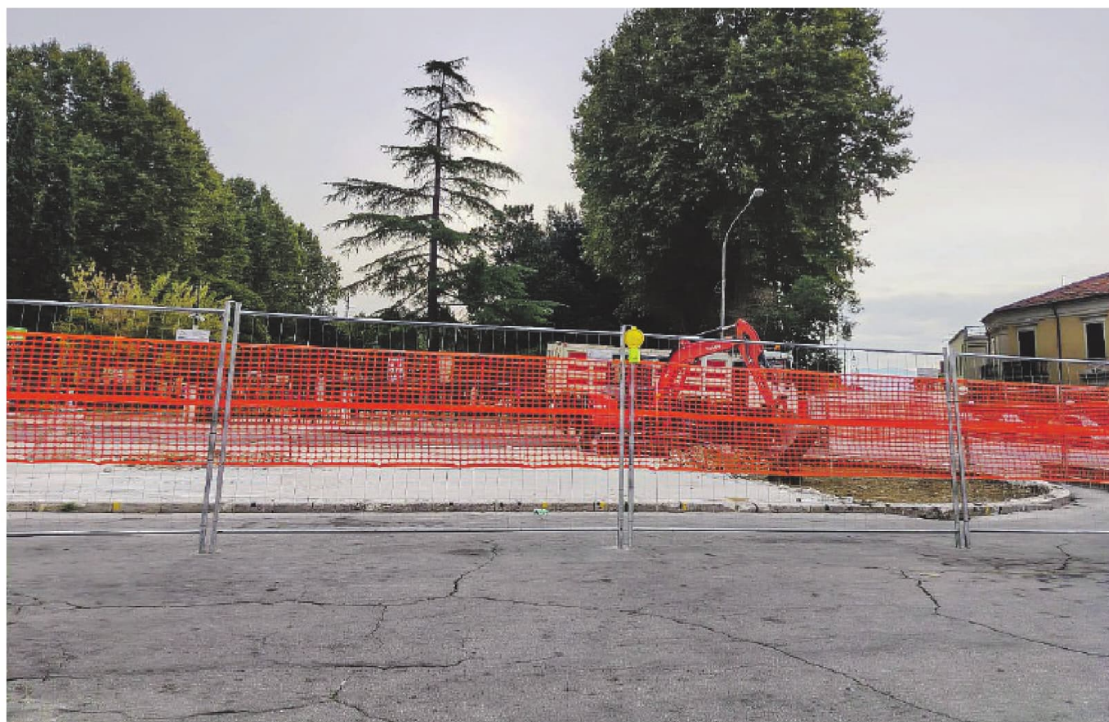
Il cantiere dei lavori in piazza Indipendenza nel centro della città
